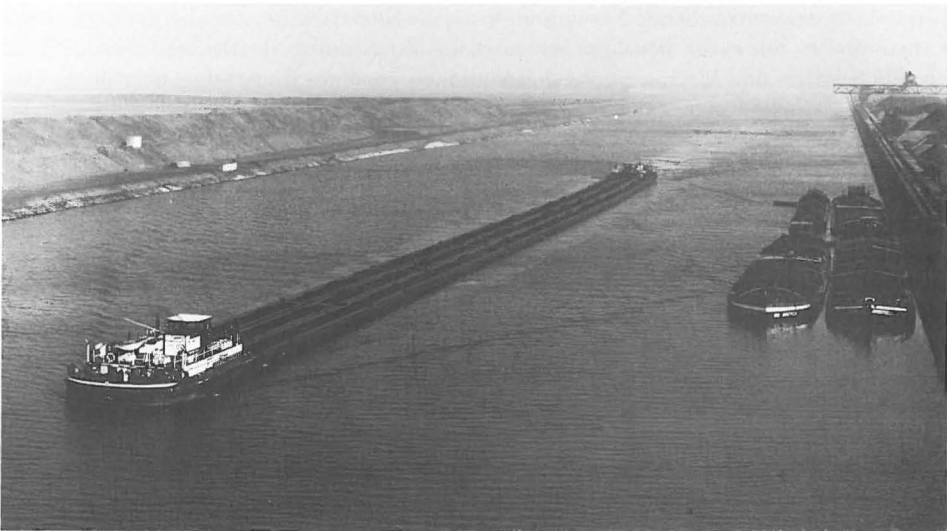
Das Lastrohrfloß erreicht den Hüttenhafen Beddingen.
