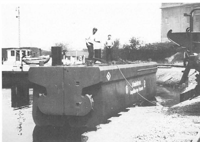
Der O&K-Behälter wird vom Landewagen der Aufschleppanlage aufgenommen und ins Wasser gesetzt.
