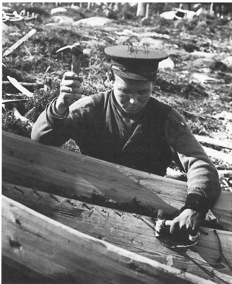
Abb. 50 Das Nähen eines sami- schen Bootes bei Nuotjaur (Notozersk) auf der Kola- Halbinsel im Jahre 1909. (Foto: Gustaf Hallström, Nordiska museet, Stockholm)
