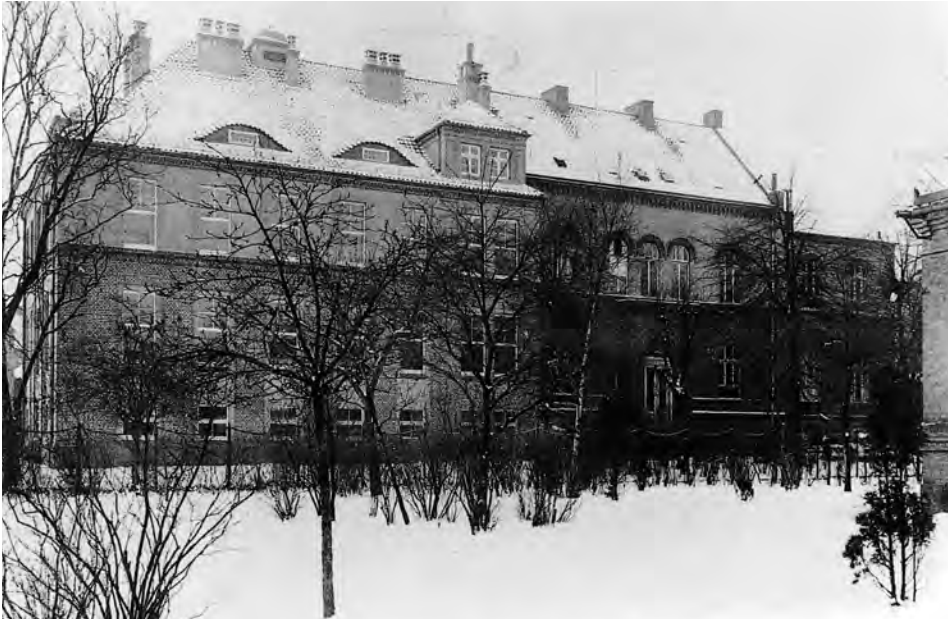
Abb. 5 Nordseite des Hygienischen Instituts in Bremen, links: der Anbau nach 1910, Mitte: das ursprüngliche Gebäude von 1890, rechts: der Anbau von 1899, Aufnahme etwa 1910. (Staatsarchiv Bremen)
