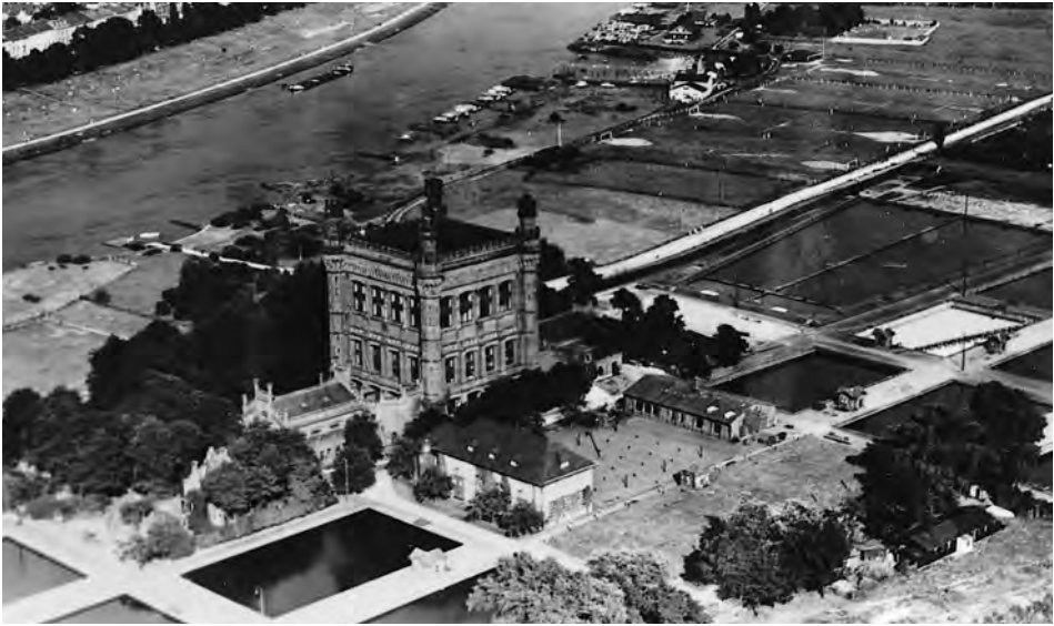
Abb. 4 Der Hochspeicher von 1873 des bremischen Wasserwerks auf dem Stadtwerder, Luftaufnahme, etwa vor 1939. (Staatsarchiv Bremen)
