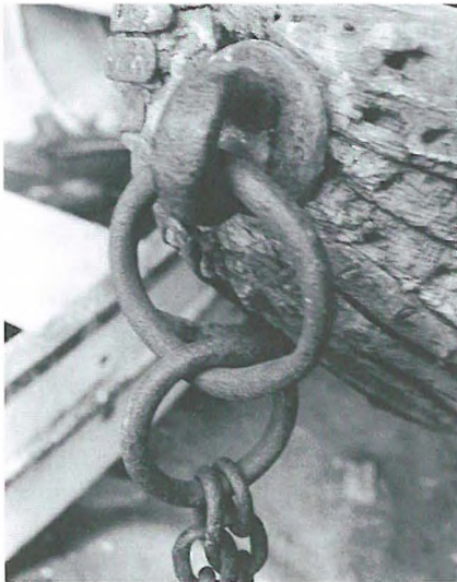
Abb. 14 Festmachring mit Eisenbolzen und Kette.
