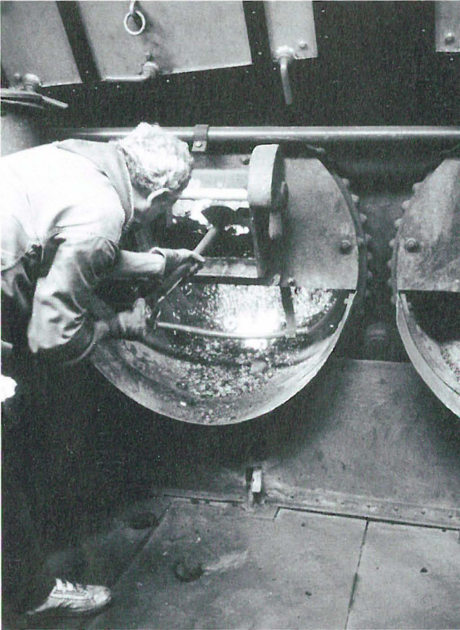
Abb. 11 Original erhaltene Kesselanlage des Dampfschleppers ANDREAS. Nur mit dem Erhalt oder Rekonstruktion solcher Anlagen ist die langfristige Bewahrung der handwerklichen Fähigkeiten des Heizerberufes möglich. Moderne Ölbrenner erlauben zwar einen ökonomischen Schiffsbetrieb, jedoch keinen authentischen Betrieb eines Museumsschiffes. (Foto: Ingo Heidbrink)
