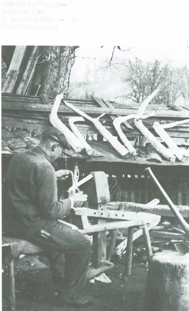
Abb. 1 Mit dem Ziehmesser werden die Holznägel zugeschnitten.
