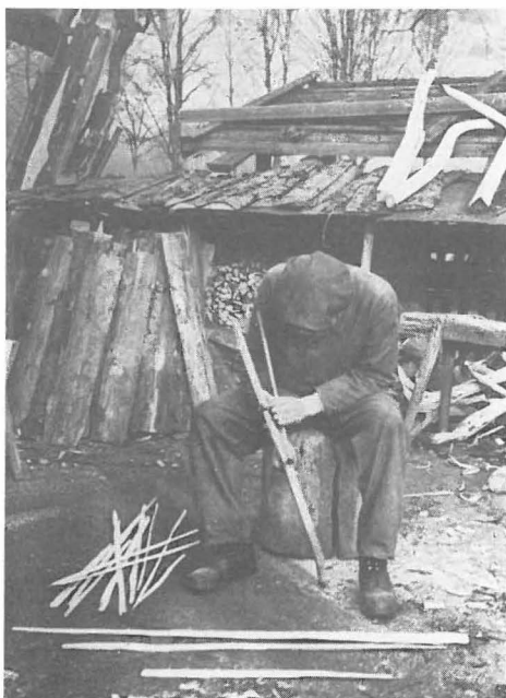
Abb. 21 Die Abdeckleiste wird zuge-schnitten.
