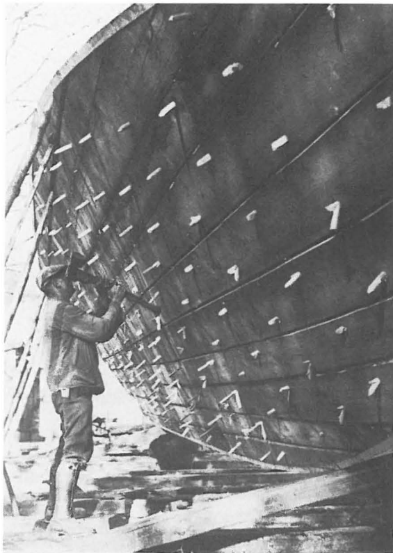
Abb. 15 Die Holznägel werden verkeilt.
