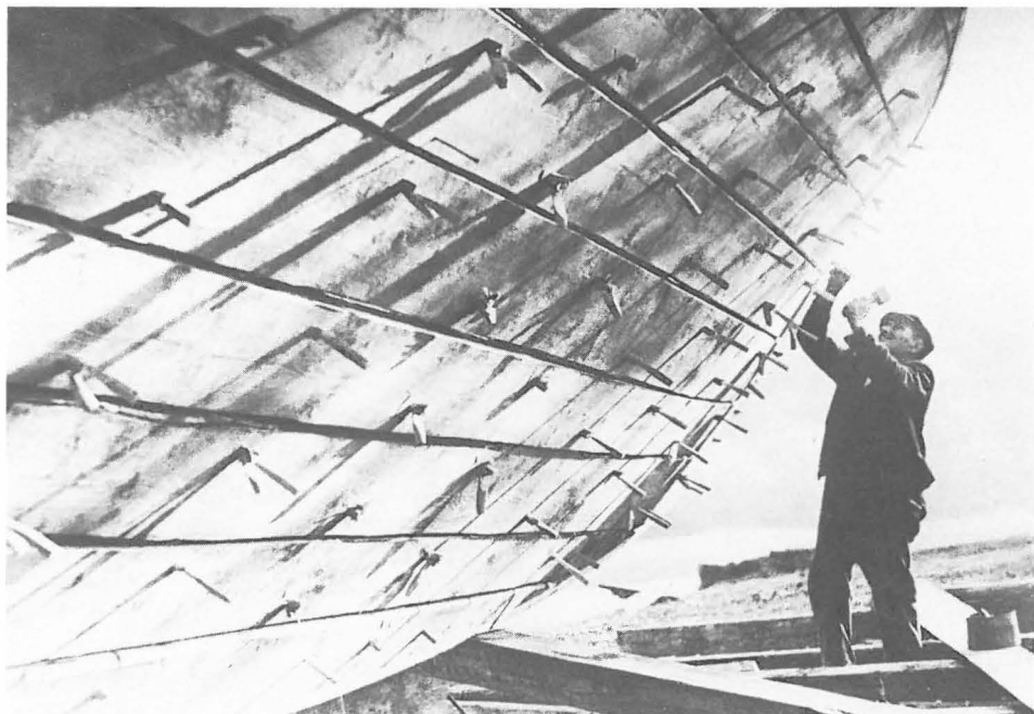
Abb. 15 Die Holznägel werden verkeilt.
