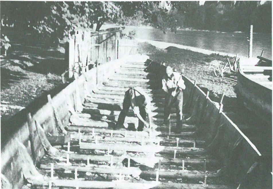
Abb. 13 Mit Holznägeln werden die Spanten befestigt.
