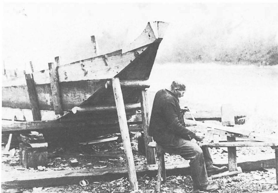
Abb. 2 Der Schiffbauer Josef Axthammer beim Abflachen der Spanten.
