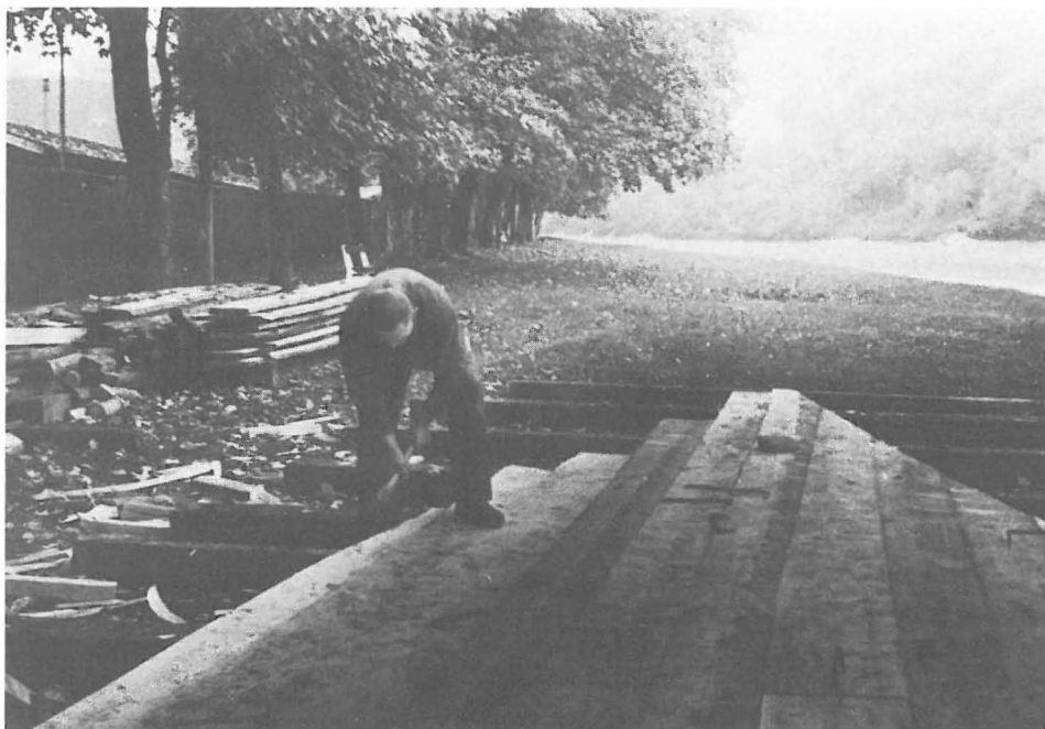
Abb. 3 Der Boden ist ausgelegt und wird zugebaut. Eisenklammern halten die Planken vorübergehend zusammen.
