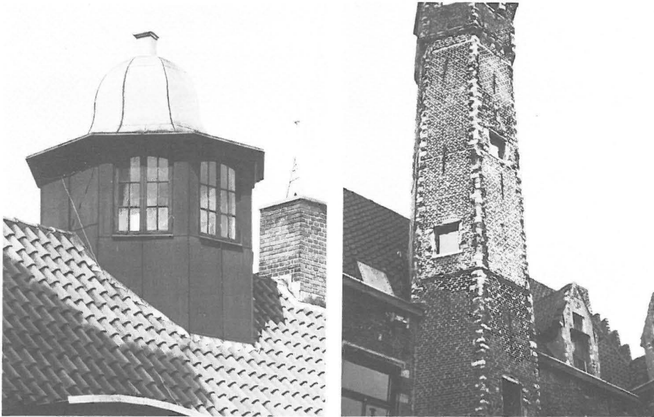
Links: Die einzige bewahrte »echte« Kiekenburg in Helsingør reitet auf dem Dach des Hauses der ehemaligen englischen Klarierfirma Belfour & Ellah, Stengade 61. Das Gebäude wurde 1789 errichtet. Der achteckige Aufbau ist rotbraun angestrichen, und das metallgraue Dach hat eine geschweifete Barockform. Von hier oben hatte man eine prächtige Aussicht über den Hafen und die Reede der Stadt und über den zwischen Helsingør und Helsingborg nur 4 km breiten Sund. (Foto: H. Hauch) – Rechts: In der alten flämischen Handelsstadt Antwerpen findet man hohe, gemauerte Türme, von denen aus man die Schifffahrt auf der Schelde beobachten konnte. Renaissance-Haus in Heilig Geest Straat. (Foto des Verfassers)
