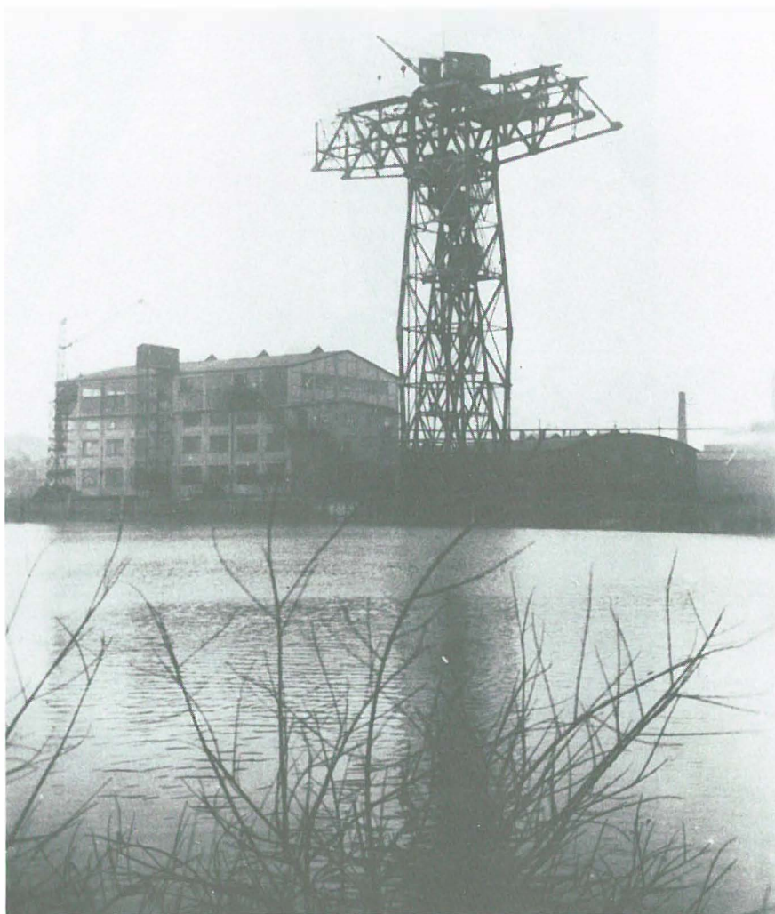
Demontage des Uferkrans auf der Tecklenborg-Werft in Wesermünde, 1928 (Archiv DSM)
