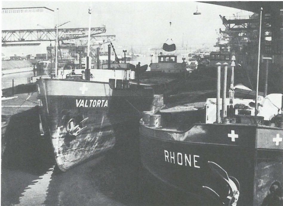
Schweizerische Rheinschiffe im Hafen von Basel 1965. Die Bugform der VALTORTA ist typisch für die schnellen Motorschiffe des Oberrheins. Der ältere Schleppkahn RHONE ist dagegen in der Art fast aller Kähne des Rheins (1920–1940) gebaut. Von diesen besaßen die Schweizer recht wenige. (WDR Köln)
