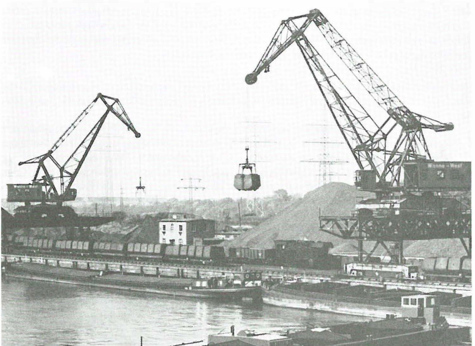
Wanne-West (1960). (Wanne-Herner Eisenbahn und Hafen GmbH. 1913–1963). – Brücken-Wippkräne waren bei der Kohleverladung unüblich und nur in großen Häfen anzutreffen.
