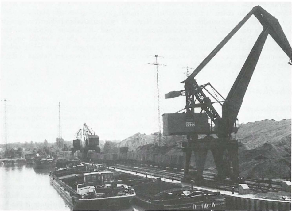
Zechenhafen Preußen, Lünen (um 1965). Der alte Kohlehafen der Zechen Preußen 1, 2 wurde vom Verbundwerk Gneisenau übernommen. Der Hafen erzielte in den sechziger Jahren seine höchste Umschlagsleistung. Drei Kräne ermöglichten damals den Umschlag von Kohle und Koks, ca. 500 000 t – 800 000 t pro Jahr. Zwei der alten Kräne wurden abgerissen; der Hafen wird zusammen mit der Zeche Gneisenau u. U. 1985/1986 stillgelegt.
