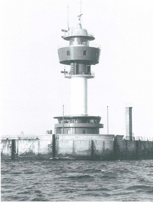
Abb. 32 Leuchtturm KIEL mit Lotsenstation in der Außenförde (1992).
