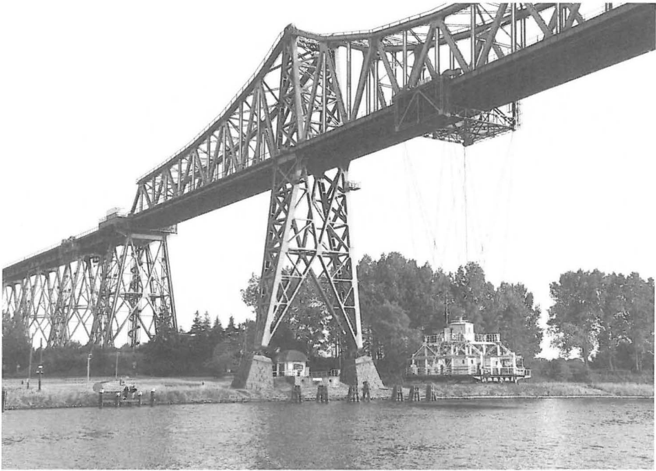
Abb. 22 Hochbrücke mit Schwebefähre in Rendsburg (1992).
