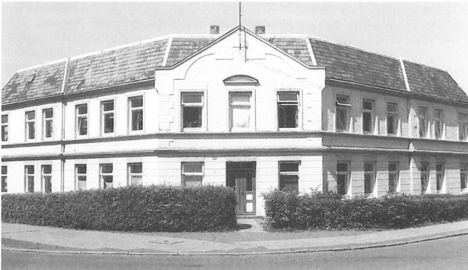
Abb. 33 Ehemaliges Wohngebäude für Kanalbedienstete aus der Gründungszeit in der Koogstraße 101 in Brunsbüttel (1988).
