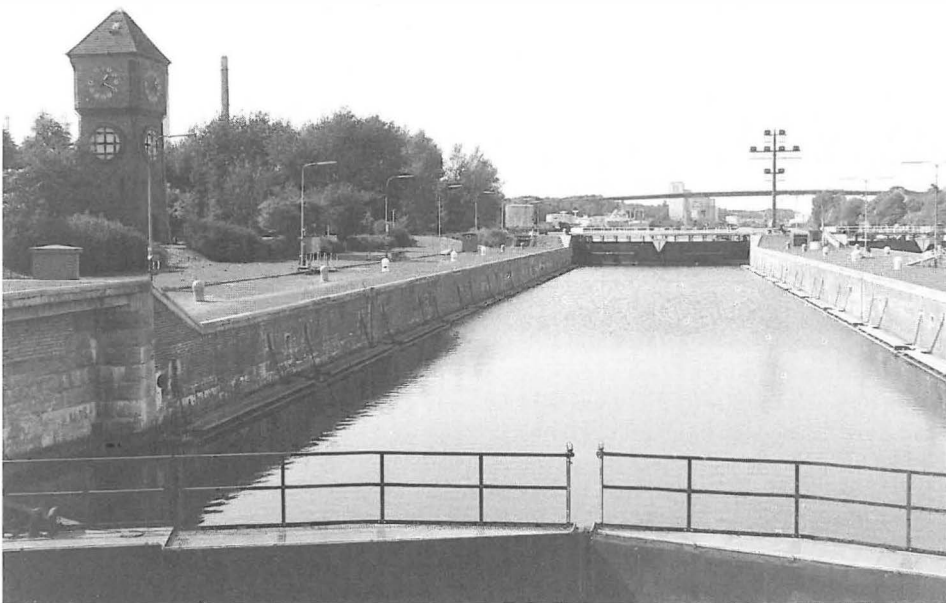
Abb. 12 Südkammer der Alten Schleusen in Kiel-Holtenau (1992).
