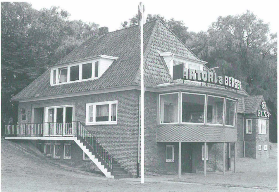
Abb. 34 Dienstgebäude an den Neuen Schleusen in Brunsbüttel (1988).
