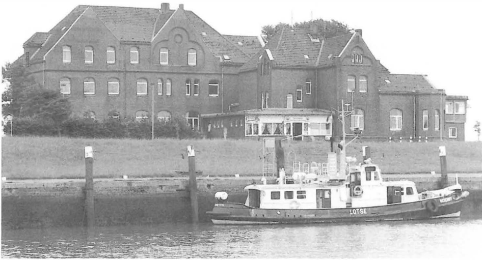
Abb. 31 Lotsenstation mit Lotsenversetzboot OSTERIFF in Brunsbüttel (1988).
