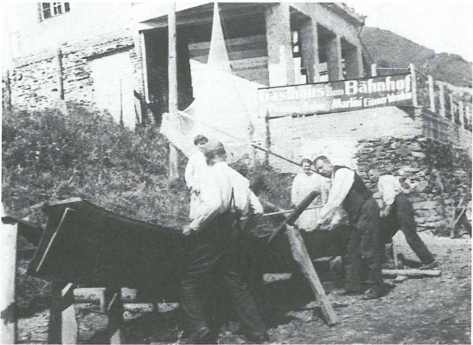
Alte Fotos geben Aufschluß über den Bootsbau in früherer Zeit. Auf dem Bild wird auf einem Bootsbauplatz am Moselufer ein Seitenbord an den Bootsboden angepaßt.
