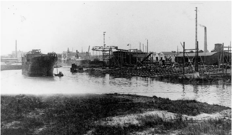
Abb. 8 Stapellauf des Frachtdampfers GERDA bei der Schiffbaugesellschaft Unterweser, 1921.
