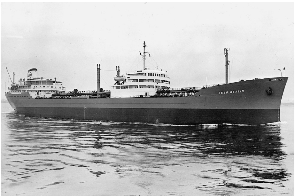
Abb. 10 ESSO BERLIN von 1958: Die Aufbauten für Brücke und Maschine sind getrennt. (Foto: Archiv DSM)
