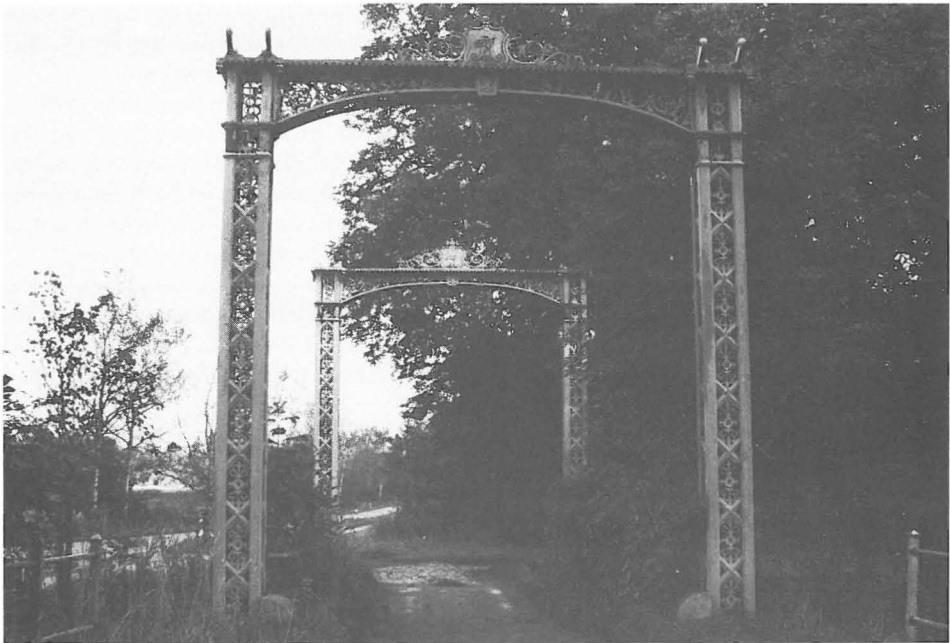
Gußeiserne Zugbrückenportale über die Schleuse des Schleswig-Holsteinischen Kanals (Eiderkanal) bei Kluvensiek (Kreis Rendsburg-Eckernförde, 1987)
