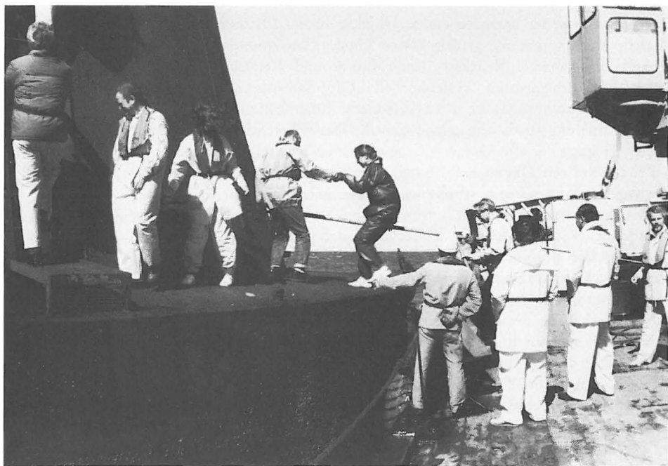
Übersetzen vom Tonnenleger auf den Turmsockel des Leuchtturms »Roter Sand« (1988)
