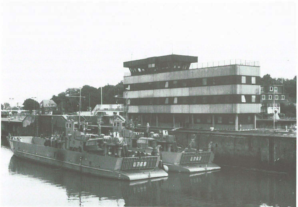
Neue Schleusen des Nord-Ostsee-Kanals in Brunsbüttel (Kreis Dithmarschen, 1988)
