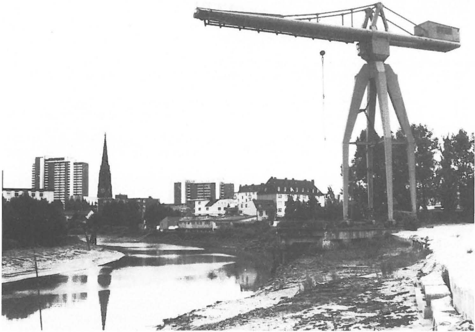
Kran und Helgenfundamente der 1986 in Konkurs gegangenen Rickmers Werft in Bremerhaven (Bremerhaven, 1989)
