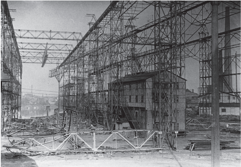
Abb. 3 Demontage der Helgengerüste auf der Tecklenborg Werft, 1928.
