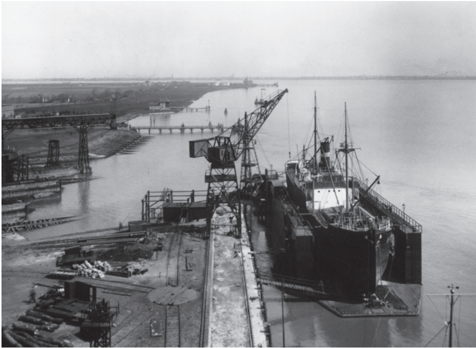
Abb. 12 Schwimmdock mit Ausrüstungskran und Helgen der Frerichswerft, um 1931.
