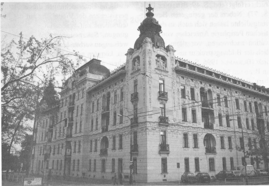
Foto 3: Brno – Sanierter Teil des Jugendstilensembles Tivoli im Wohnviertel Veveří (Stadtteil Brno-střed)
