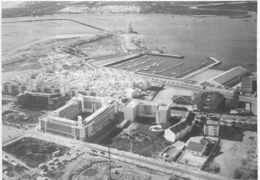
Foto 2: Der Sporthafen Isla Cristinas und das südliche Erweiterungsgebiet 1993 Quelle: privat
