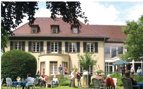
Außenansicht der Villa Donnersmarck nach dem Umbau
