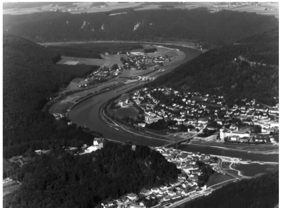
Abb. 1: Main-Donau-Kanal – Staustufe Riedenburg
