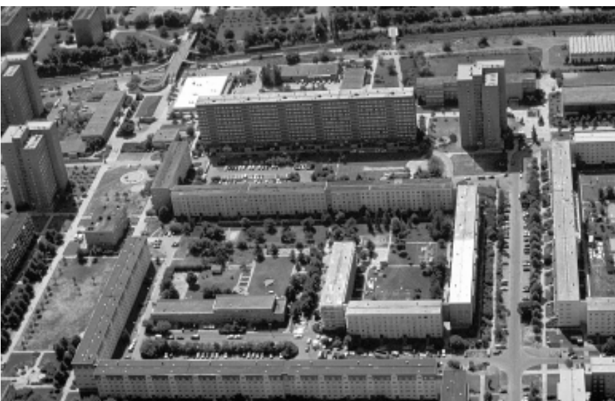
Foto 2: Sanierte Plattenbauten in Leipzig-Grünau 1995
