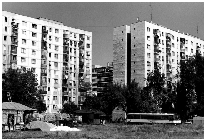
Foto 5: Die vielgeschossigen Wohngebäude in der Großsiedlung Bukarest, Drumul Taberei (155 000 Einwohner, 65 520 Wohnungen, errichtet 1955-1990) spiegeln den hohen Sanierungsbedarf der Gebäudesubstanz wider.
