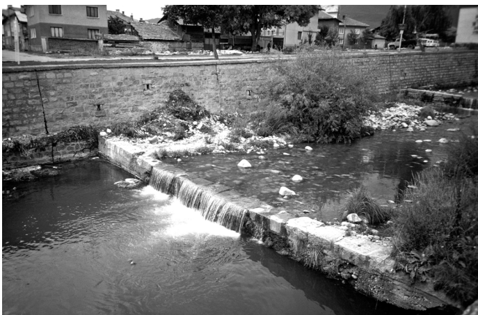
Foto3: Gewässerverbau und Abfall im Gewässerbett charakterisieren Abschnitte des Flusses Glazne in Bansko
