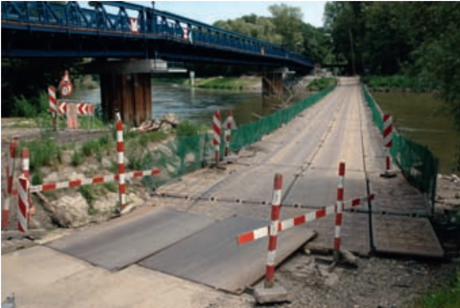
Foto 2: Grenzöffnung light: Alte Pontonbrücke und neu fertige gestellte feste Pionierbrücke zwischen Hohenau und Moravský Svätý Ján Foto: Ch. FRIDRICH, Mai 2005
