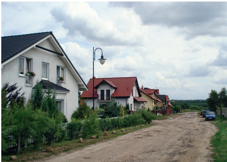
Foto 3: Infrastrukturmängel am Stadtrand von Poznań Foto: Radzimski 2010
