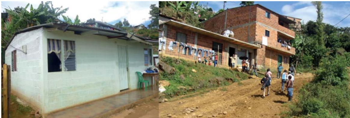
Foto 4. Estado de algunas viviendas
