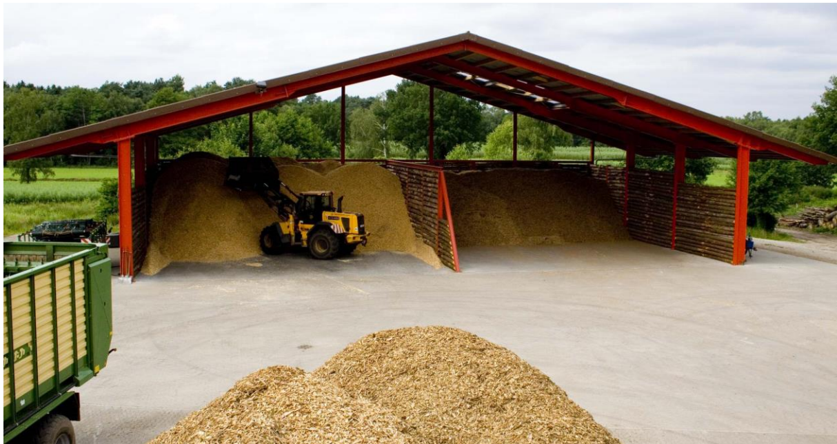
Abb. 39: Hackschnitzellager der Firma Hüttmann am Firmensitz in Soltau
