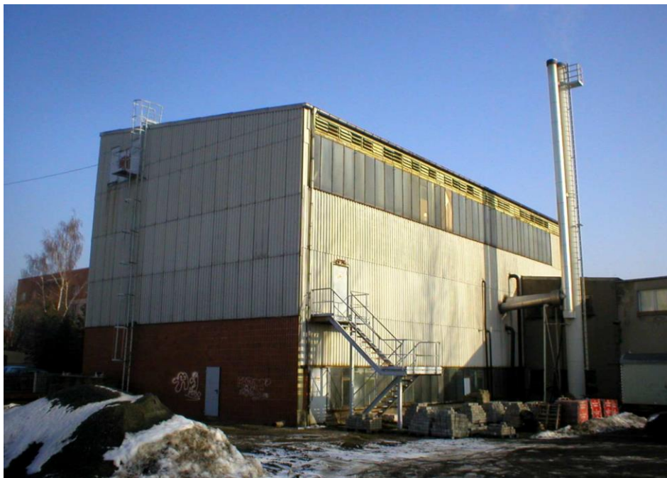
Abb. 14: Nahwärmenetz Heizhaus Grimma-West vor der Sanierung (Gesamthöhe rd. 15 m)
