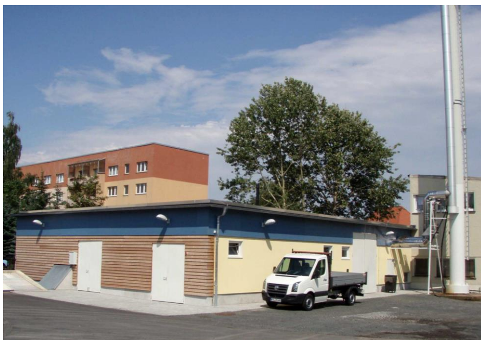
Abb. 15: Nahwärmenetz Heizhaus Grimma-West nach der Sanierung (Gesamthöhe rd. 15 m)
