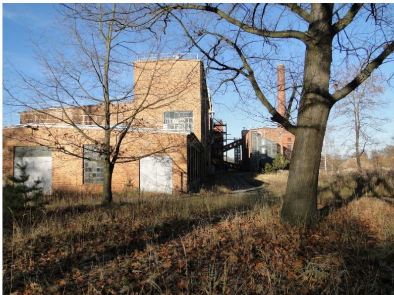
Abb. 18: Ehemaliges Heizhaus der Energiefabrik als möglicher Standort der Holzheizung Foto: Kreisforstamt Bautzen
