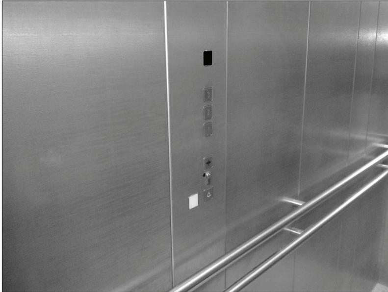
Foto 10: nicht barrierefreie Bedienungselemente im Innenraum eines Fahrstuhls
