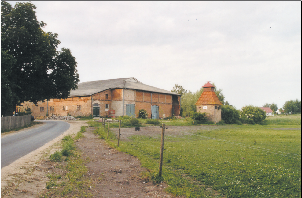
Abb. 5: Die Scheune und das Transformatorienhaus von Duckwitz
