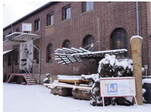
Abb. 3: Werkstattgebäude der Werkstatt eG
