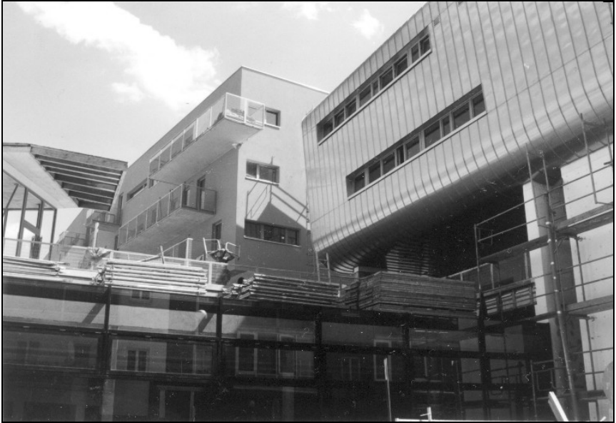
Abbildung 21: Compact City, Wien 21: Rückansicht Straßenbebauung
