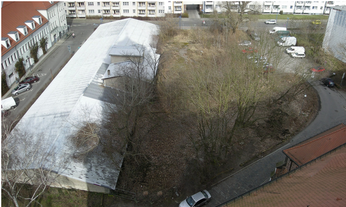
Abb. 3: Ansicht vom Domturm
