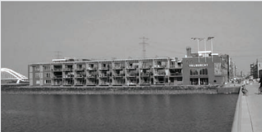
Figure 6.7 Vrijburcht –Steigereiland IJburg Amsterdam (Source: Hein de Haan)
