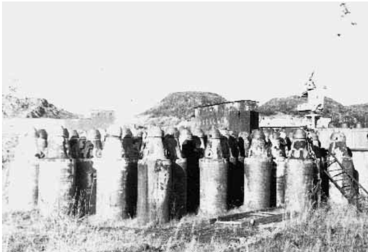
Abb. 6: Beschädigte Container gefüllt mit abgebrannten Brennelementen in Andreeva Bay
