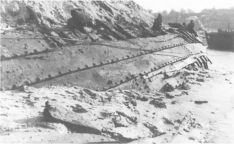
Abb. 1 Die Bremer Hanse-Kogge taucht 1962 bei Baggerarbeiten in der Weser auf. Photo: Focke-Museum Bremen
