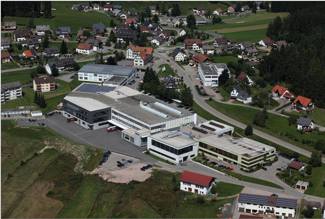
Abb. 4: Durchmischung von gewerblich-industrieller und wohnlicher Nutzung in Eisenbach (Hochschwarzwald), Ortsteil Eisenbach, Bereich „Höchst“ – die Firmen F. Morat & Co. GmbH, Framo Morat GmbH & Co. KG und Grieshaber Feinmechanik GmbH & Co. KG
