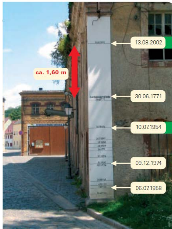
Figure 14 Water level of historic floods, on the Großmühle building in Grimma centre (Landestalsperrenverwaltung des Freistaates Sachsen, 2006).
