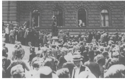
Bild 10: Justizpalast Hauptfront, ca. 12.15 Uhr: Demonstranten stehen um den Justizpalast und dringen in das „eroberte“ Gebäude ein, so auch eine Frau durch ein Parterre-Fenster (BPD).
