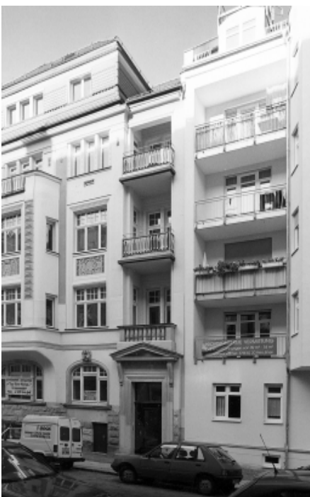
Foto 5: Saniertes und neues Wohngebäude in der Kreuzstraße
