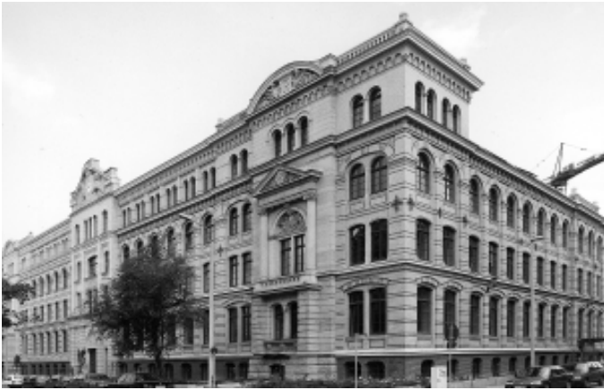
Foto 1: Das Reclam-Carree, Inselstraße/Kreuzstraße (Saniertes Reclam-Verlagshaus)
