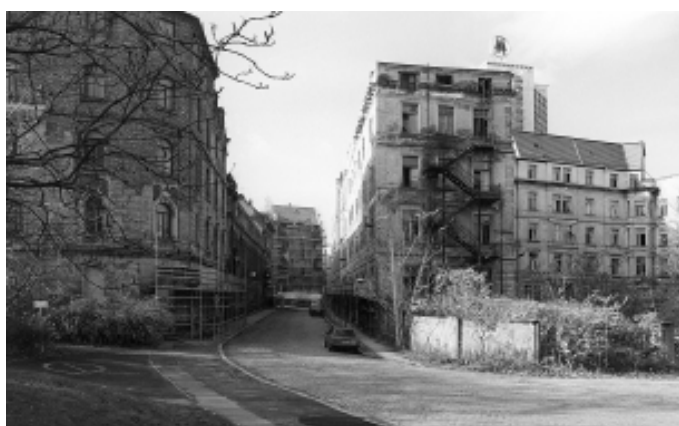
Foto 9: Unsanitierte Wohn- und Gewerbegebäude in Gemengelage, Czermaks Garten
