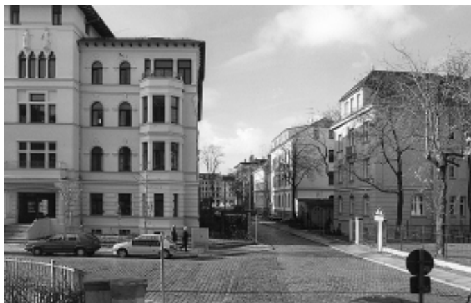
Foto 7: Sanierte Wohn- und Dienstleistungsgebäude Salomonstraße/Chopinstraße
