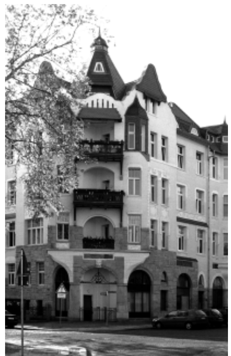
Foto 6: Saniertes gründerzeitliches Wohngebäude Chopinstraße/Hans-Poeche-Straße
