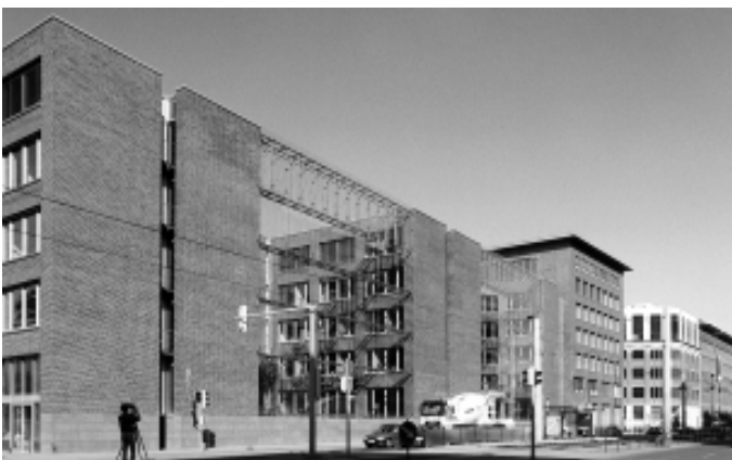
Foto 3: Neubau Haus des Buches sowie Sanierung bzw. Neubau Seemann-Carree, Prager Straße
