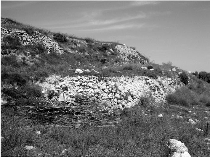
*Foto 3: Prozess der Schädigung von Hangterrassen in Malta: Die obere Terrasse ist bereits stark erodiert, das Geröll der oberen Mauer schädigt die darunter liegende Terrasse*
