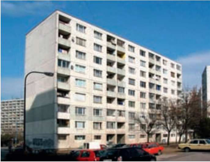
Foto 4: Pilotprojekt „Umfassende Sanierung eines Wohnblocks in Bratislava-Petržalka“ Foto: J. HUEMER 2006
