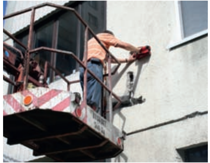
Foto 5: Lagefeststellen der Bewehrung an der Südfassade mit Hilfe eines Eisensuchgerätes durch Mitarbeiter des Magistrat Wien, MA39, Bratislava-Petržalka Foto: V. MAYER 2006
