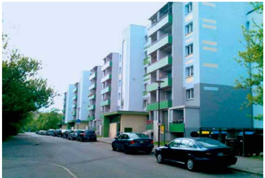
Foto 2: Nachträglich angebrachte Fahrstühle für einen barrierefreien Zugang zu Wohnungen in einem Wohnblock in Halle (Saale) (F. Ringel, 9.5.2013)
