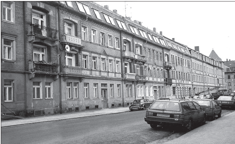
Abb. 2.4.2: Geschlossene Blockbebauung der Baujahre bis 1918 in Pieschen (Foto: Effenberger)
