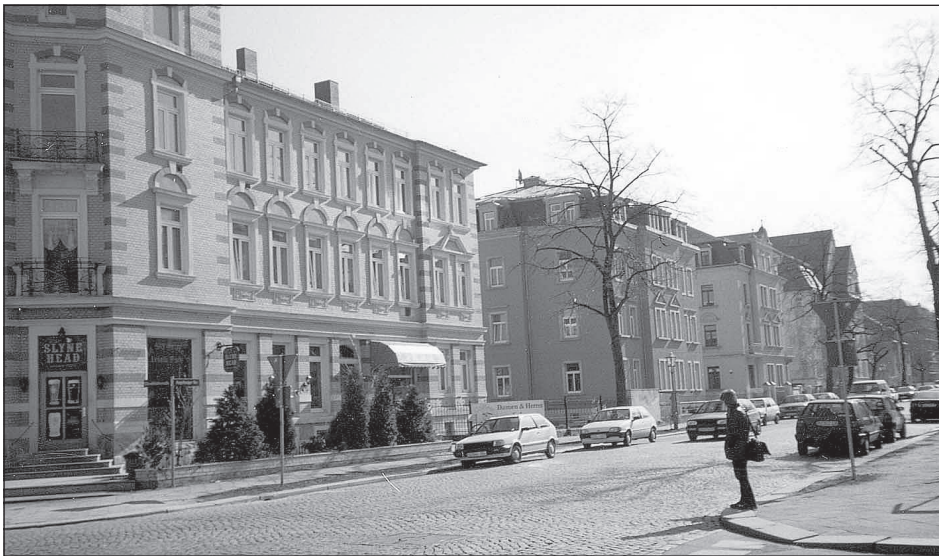
Abb. 2.4.3: Offene Blockbebauung der Baujahre bis 1918 in Striesen (Foto: Effenberger)
