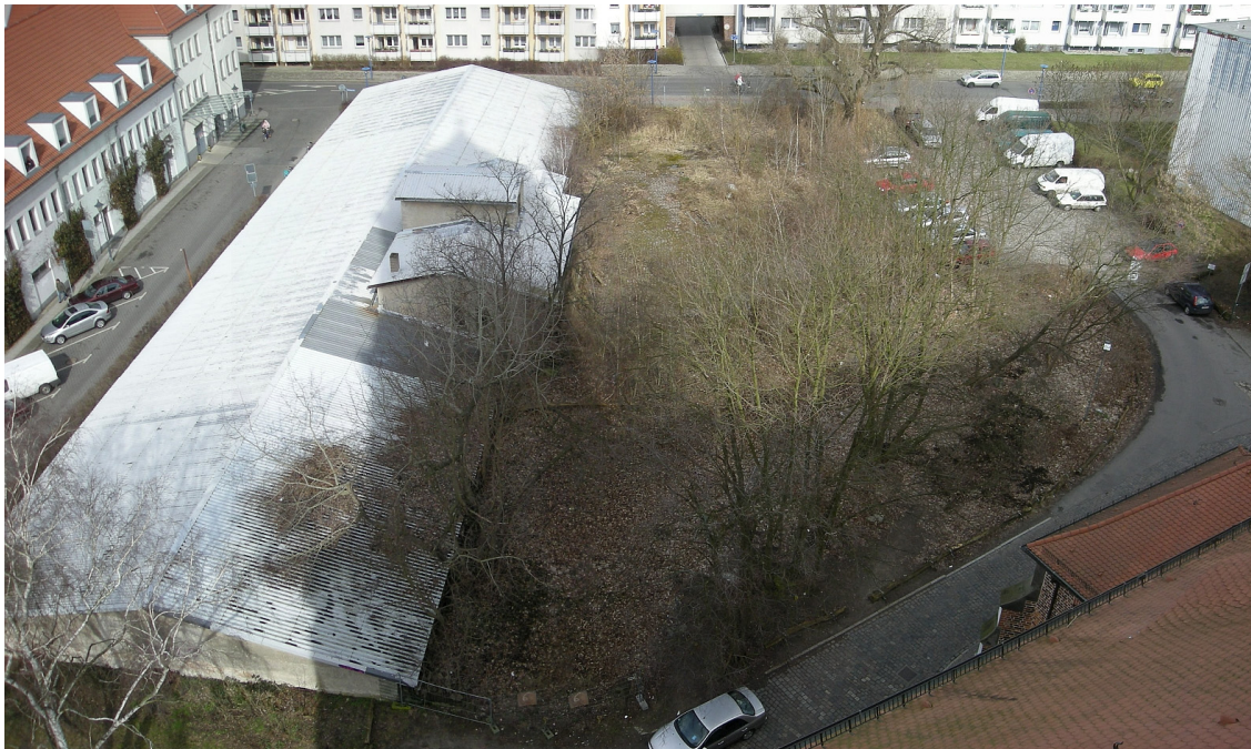
Abb. 3: Ansicht vom Domturm
